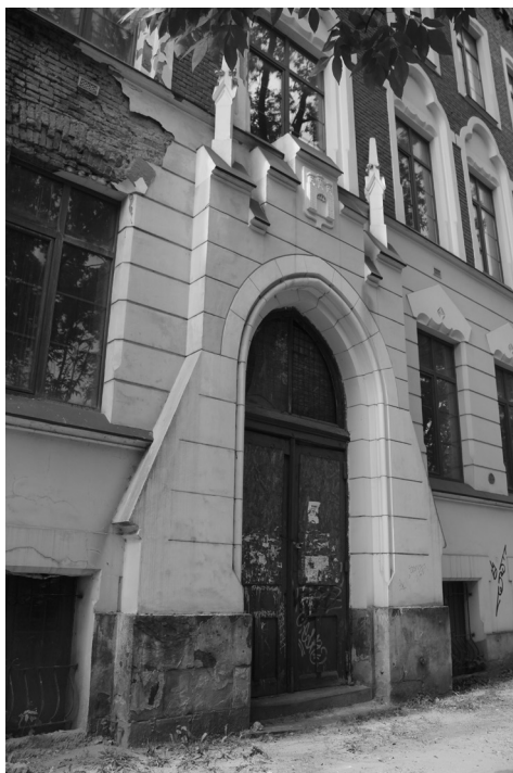
Szkoła Sienkiewicza – wejście, 2019. Fot. J. Komorowski
