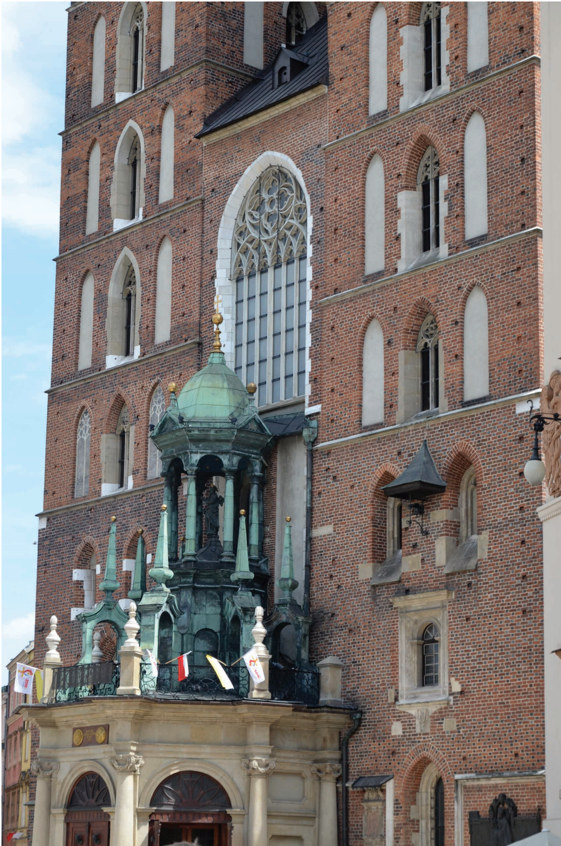
4. Kraków, kościół Mariacki, dolna część masywu wieżowego od zachodu. Fot. Piotr Pajor
