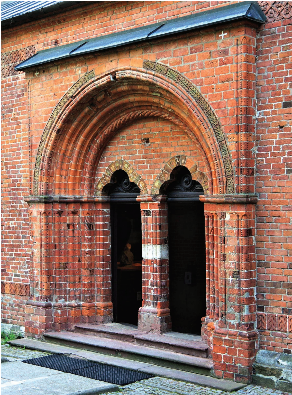
2. Sandomierz, kościół św. Jakuba, portal główny, widok od północnego-zachodu. Fot. Jakub Jurkowlaniec, lipiec 2020
