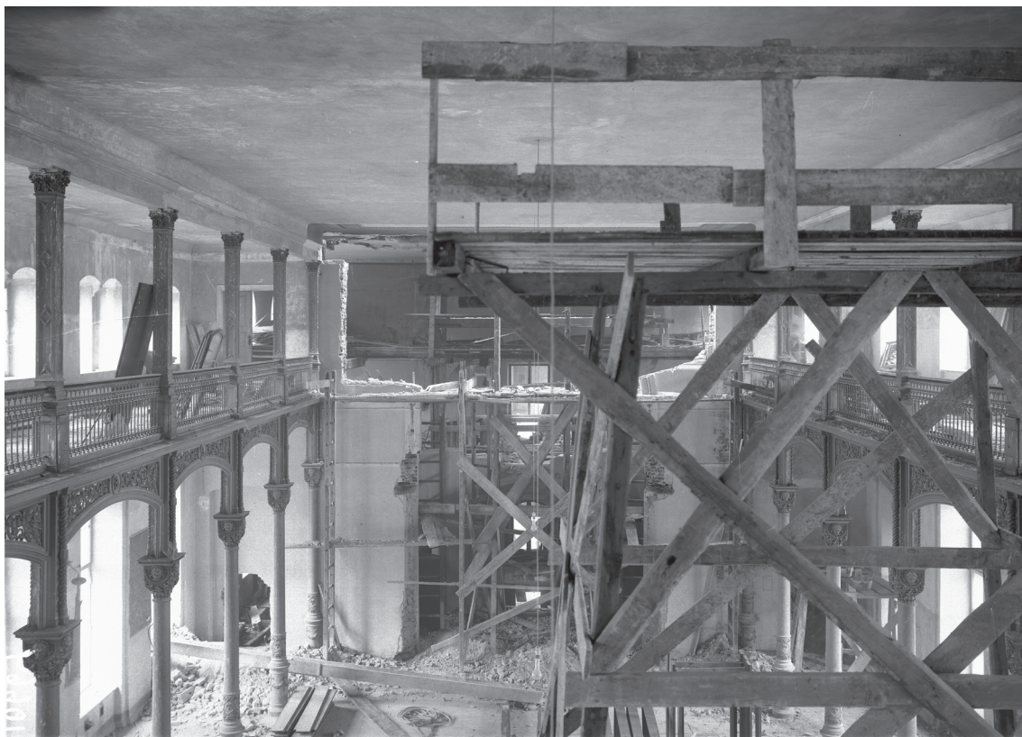
8. Jadalnia w Instytucie Aleksandryjsko-Maryjskim w czasie przebudowy na salę plenarną Sejmu RP, fotografia ze stycznia 1919 r. Fot. IS PAN, neg. 10664
