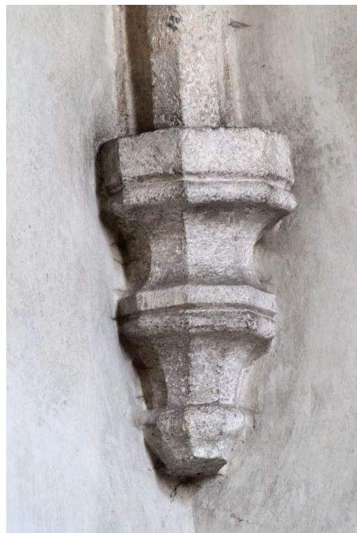
22. Kościół Bożego Ciała w Krakowie, wspornik sklepienia w kaplicy św. Anny. Fot. Wojciech Sowała
