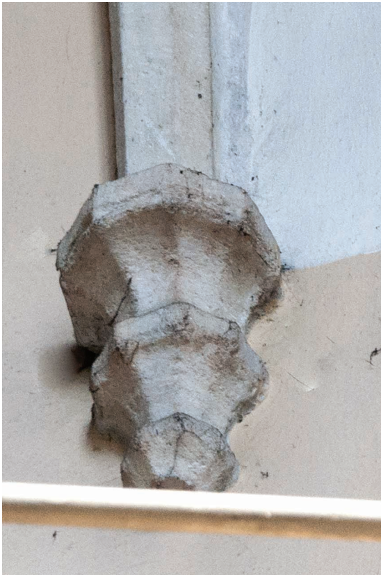
13. Kościół św. Jana Chrzciciela w Skalbmierzu, wspornik sklepienia w prezbiterium. Fot. Wojciech Sowała
