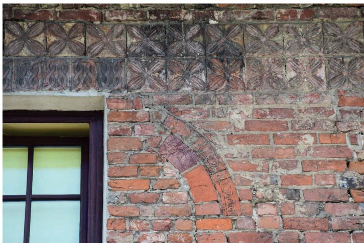
14. Sandomierz, klasztor dominikanów, dekoracje ceramiczne wschodniej elewacji skrzydła wschodniego. Fot. Justyna Kamińska, 2019
