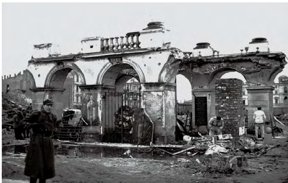
10 Prace przy odbudowie Grobu Nieznanego Żołnierza w Warszawie w kwietniu 1946 r. Fot. Narodowe Archiwum Cyfrowe, sygn. 3/27/0/-/826/5
