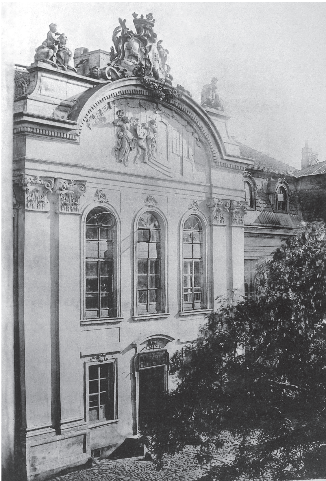
5. Pałac Franciszka Bielińskiego przy ul. Królewskiej w Warszawie, przed 1722, gruntownie przekształcony ok. 1744 do ok. 1752/1753 według projektu Jakuba Fontany, zburzony 1895, ryzalit główny. Fot. przed 1895, IS PAN
