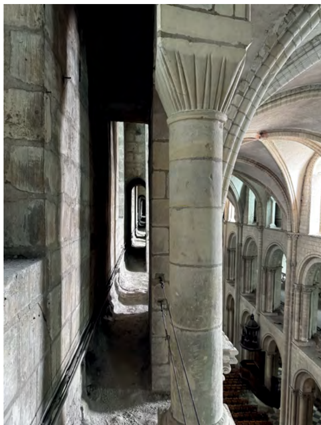
16 Kościół opacki Saint-Étienne w Caen, 1066–1090, północna kondygnacja okienna z korytarzem, widok z pasażu w murze północnej wieży ku wschodowi. Fot. Klaudia Śnieżek
