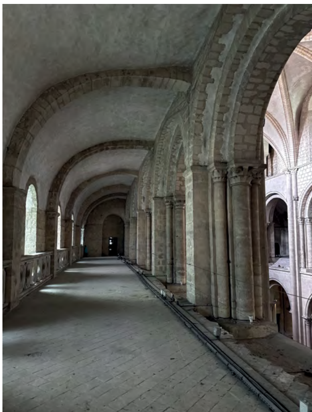
15 Kościół opacki Saint-Étienne w Caen, 1066–1090, arkada prowadząca do pomieszczenia na piętrze wieży, w obecnym stanie częściowo zamurowana, widok z empory nad nawą południową. Fot. Klaudia Śnieżek
