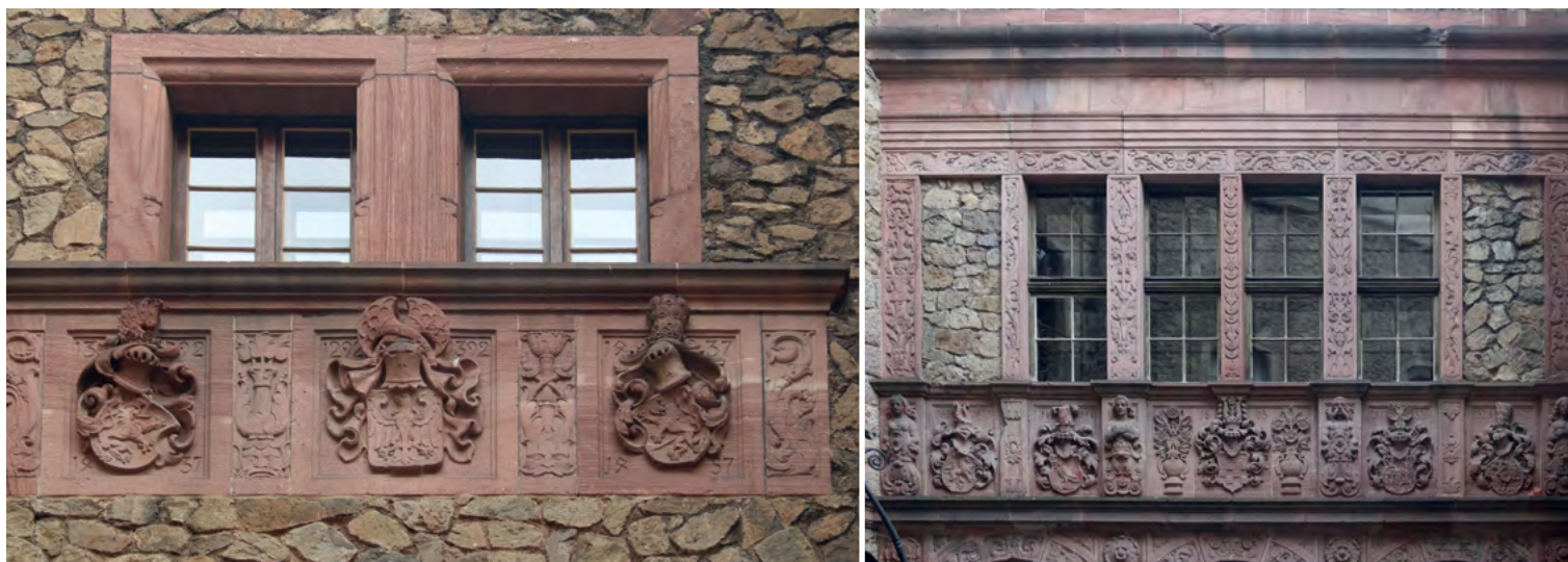
3 Zamek Książ, Czarny Dziedziniec, fragment ściany południowej z dekoracją heraldyczną: a. poziom trzeciej kondygnacji; b. poziom drugiej kondygnacji. Fot. Agnieszka Gryglewska, 2022
