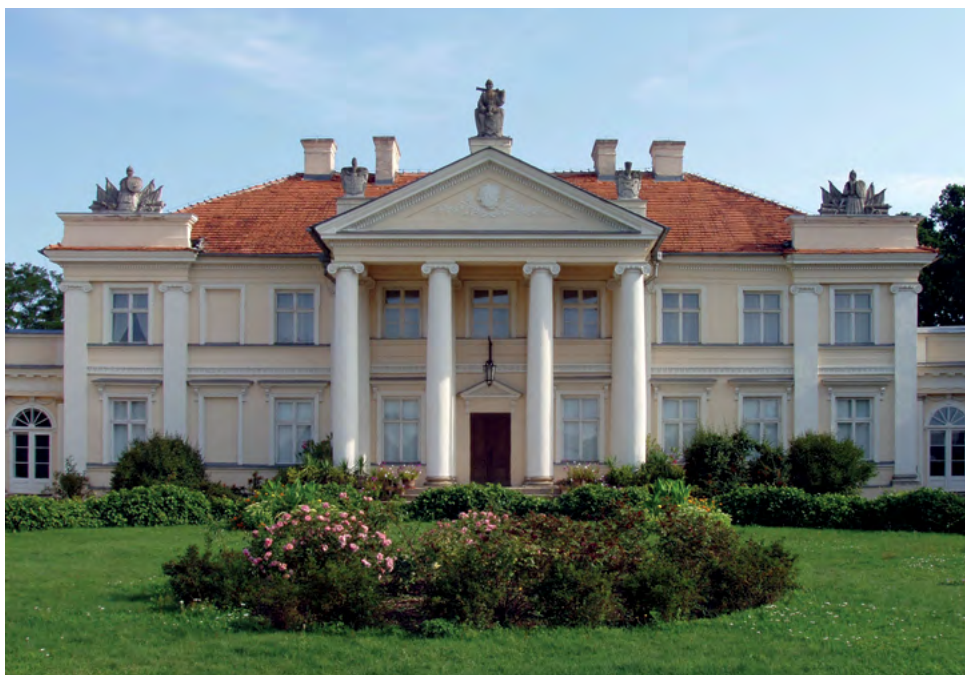
10 Śmiełów, pałac Gorzeńskich, widok fasady, stan obecny. Fot. Ryszard Mączyński
