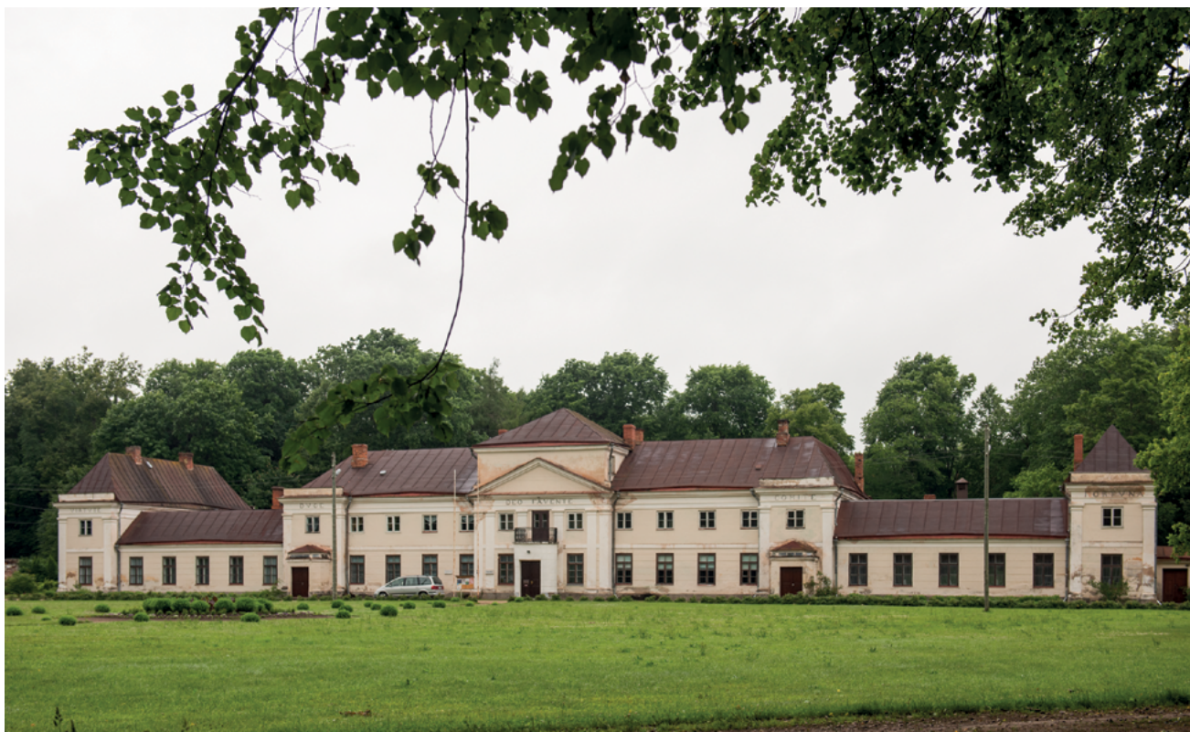
2 Warklany, pałac, widok od wjazdu, stan z 2017 r. Fot. Piotr Jamski
