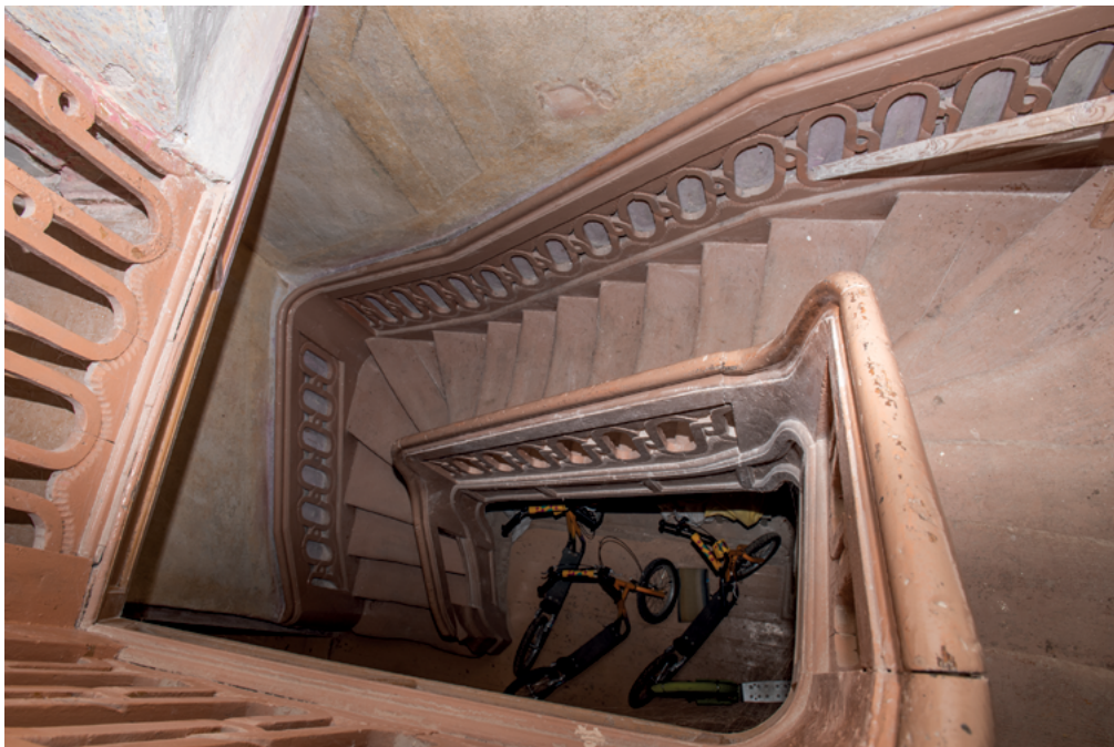
10 Warkłany, pałac, klatka schodowa, stan z 2017 r. Fot. Piotr Jamski
