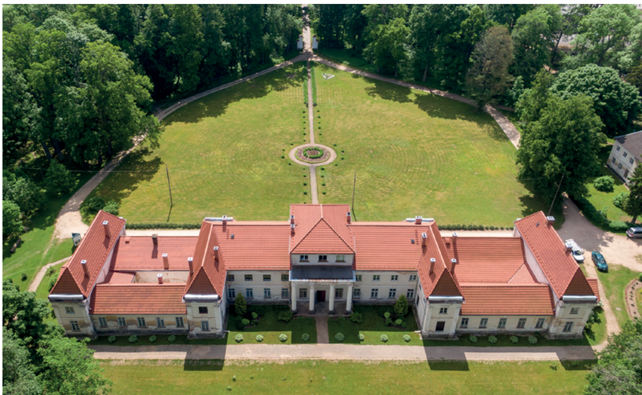
3 Warkłany, pałac, widok z góry, stan obecny. Fot. Varakļānu Novada muzejs
