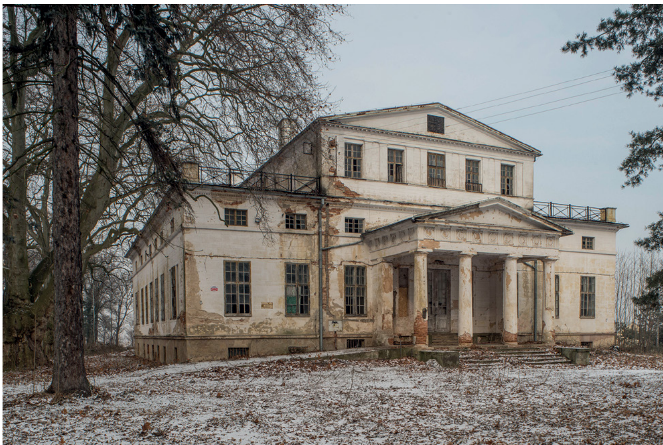
12 Pałac w Szymanowie, ok. 1826, fasada. Fot. Jerzy K. Kos
