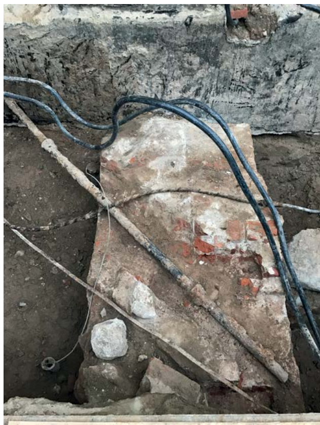
8 Warszawa, Villa Regia, południowy mur fundamentowy zewnętrznej klatki schodowej, widoczna dwufazowość konstrukcji (lewa część starsza). Fot. Hubert Kowalski
