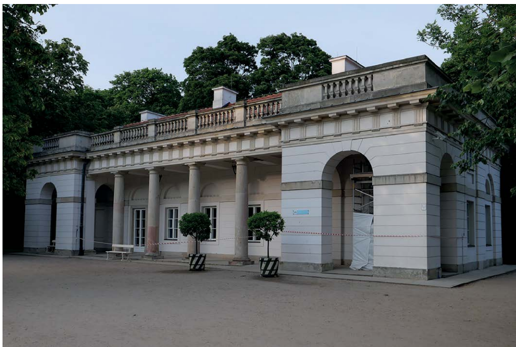
9 Stara Kordegarda w Łazienkach Królewskich w Warszawie. Fot. Paweł Dettloff
