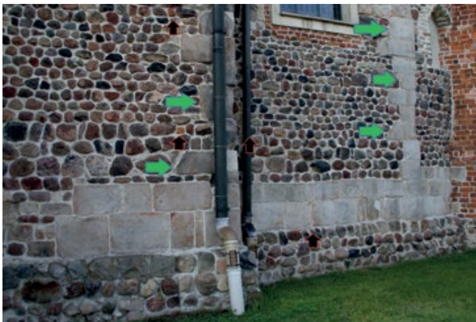
15 Kazimierz Biskupi, kościół św. Marcina, fragment południowej elewacji kościoła na styku nawy i prezbiterium. Oprac. Adam Soćko Pionowymi strzałkami oznaczono inkluzje ceramiczne, poziomymi strzałkami wskazano wtórnie użyte ciosy o zmodyfikowanym kształcie.
