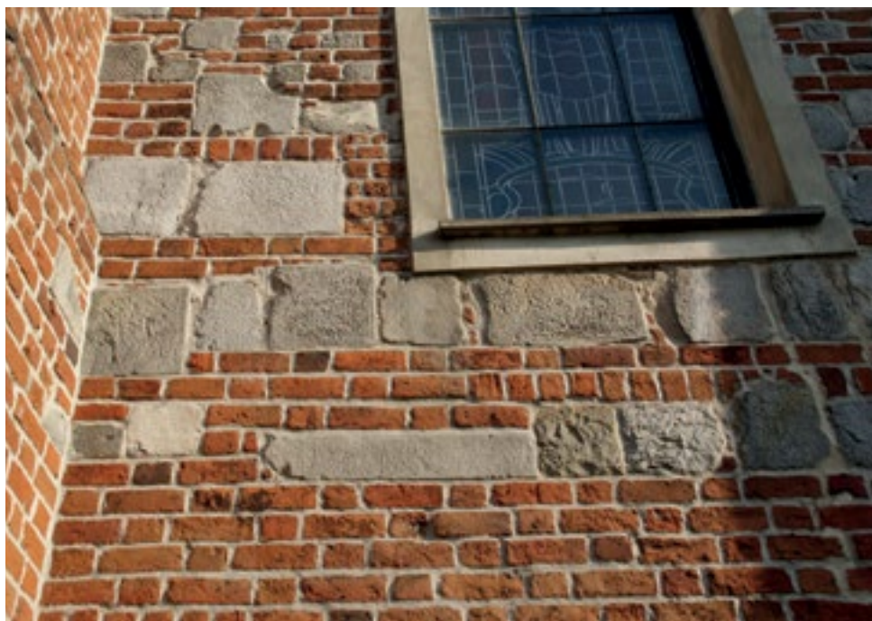
21 Kazimierz Biskupi, kościół św. Marcina, fragment lica drugiego od zachodu przeszła ściany północnej nawy z widocznymi wtórnie użytymi ciosami z dawnej świątyni romańskiej. Fot. Adam Soćko
