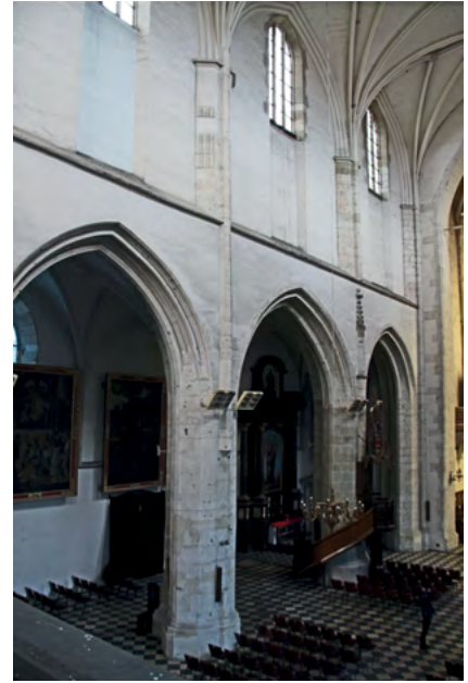
30 Kraków-Kazimierz, kościół Augustianów-Eremitów, północna elewacja nawy głównej. Fot. Jakub Adamski
