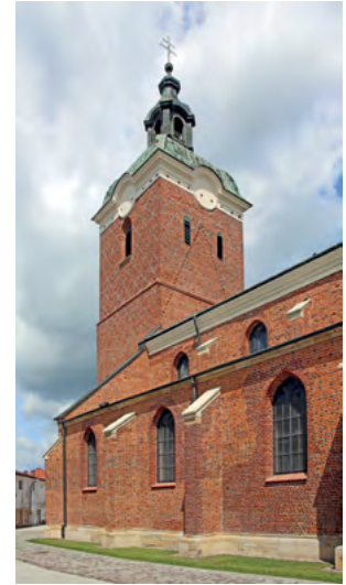
16 Przeworsk, kościół farny (d. Bożogrobców), południowa strona korpusu z pierwotnym półszczytem nawy bocznej. Fot. Jakub Adamski
