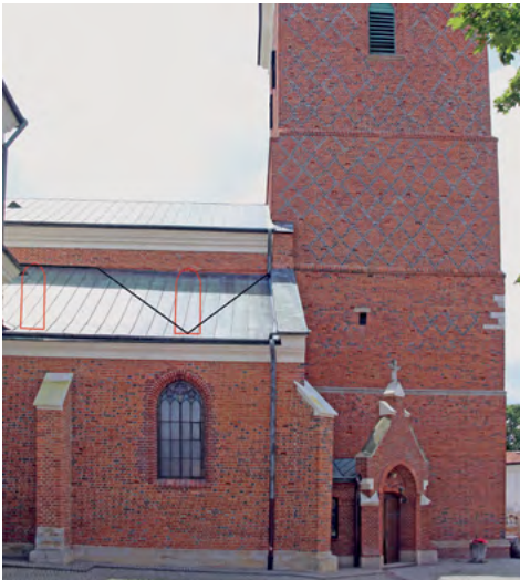
7 Przeworsk, kościół farny (d. Bożogrobców), zachodni skraj korpusu i wieża od północy, ze schematycznym zaznaczeniem układu reliktywów wcześniejszego dachu. Fot. Jakub Adamski
