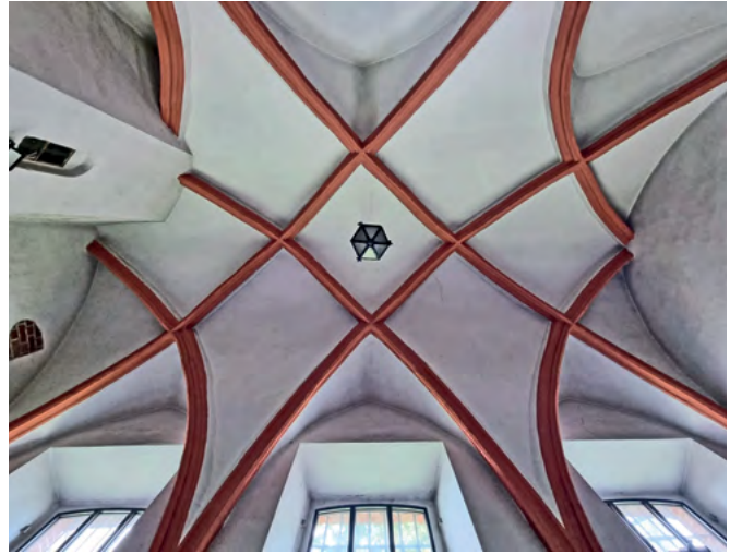
38 Przeworsk, kościół farny (d. Bożogrobców), sklepienie zakrystii. Fot. Jakub Adamski
