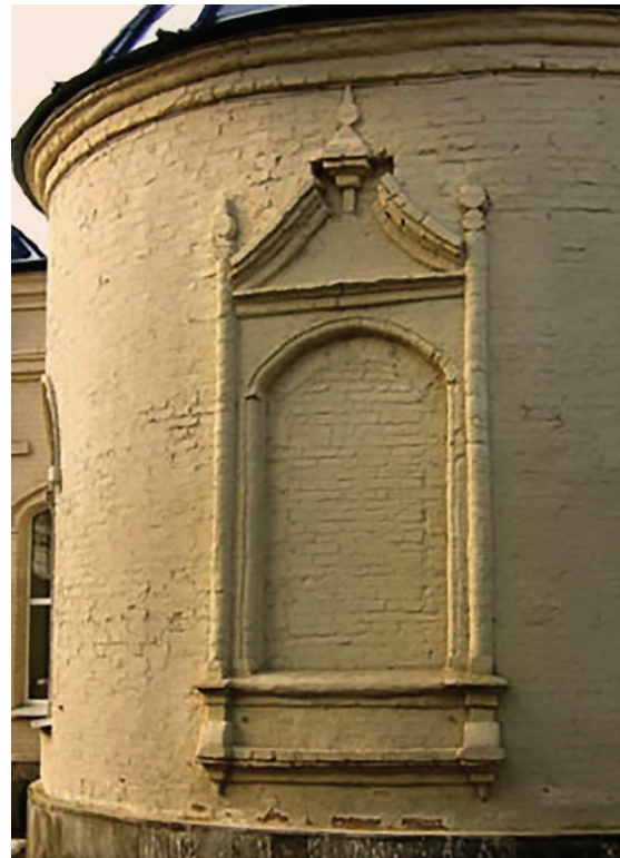
12. Obramienie okna cerkwi Kazańskiej (d. Pokrowskiej). Fot. Wiktor Atapin
