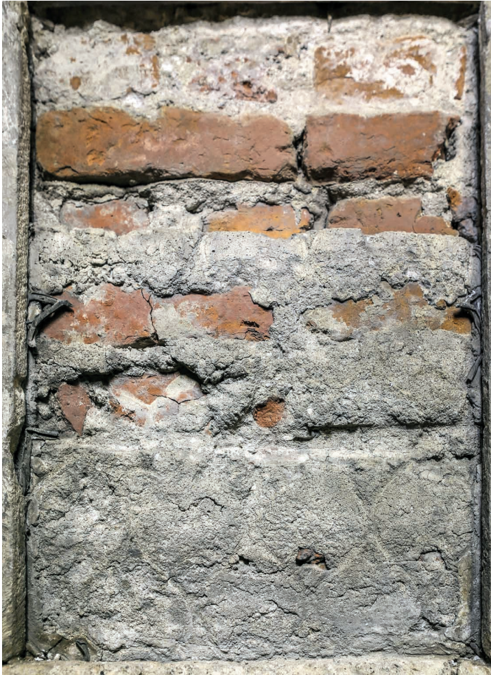
3. Ślady przeszkleń ornamentalnych okna sII prezbiterium kościoła par. pw. Bożego Ciała w Krakowie. Fot. D. Horzela
