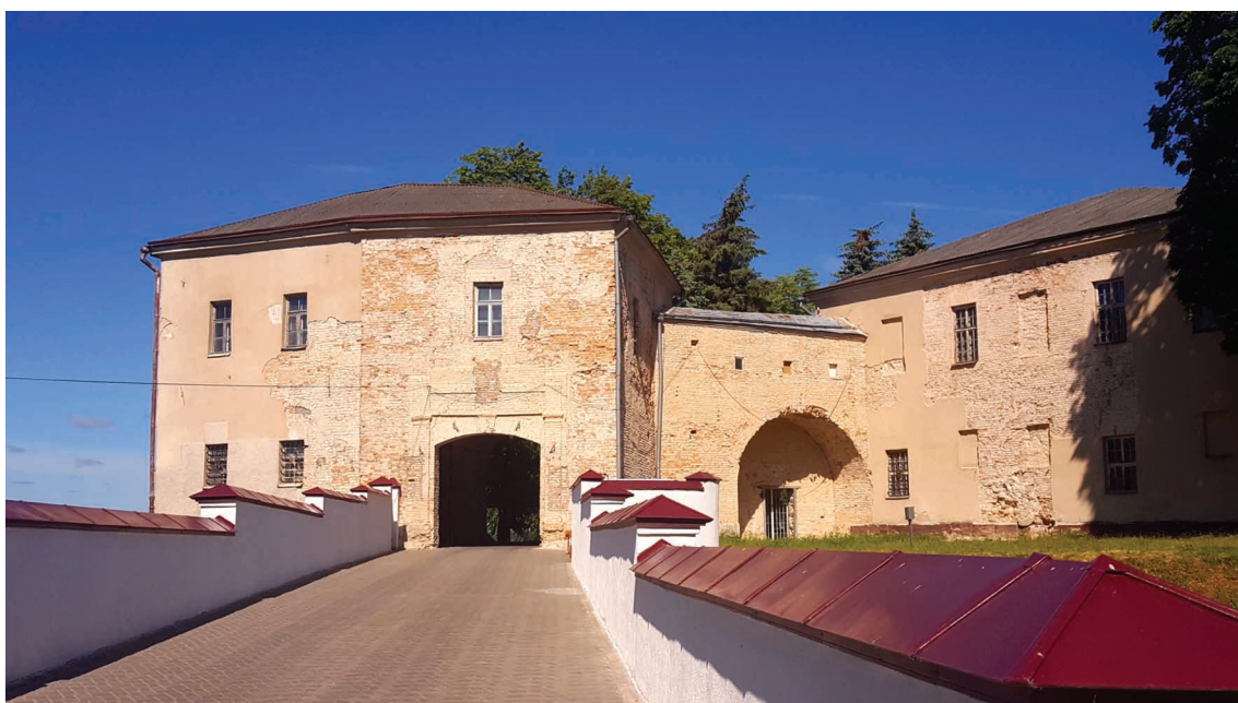
8. Widok Starego Zamku w Grodnie od strony południowej przed rozpoczęciem prac rekonstrukcyjnych. Fot. Łukasz Malczewski
