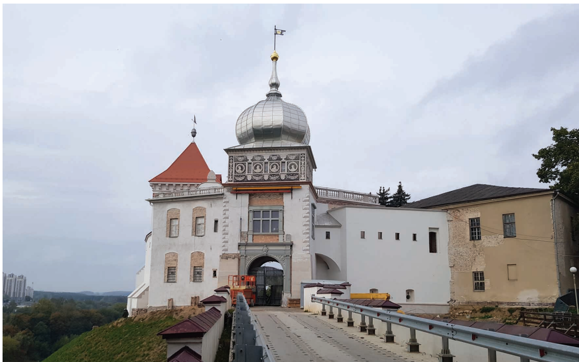
9. Widok Starego Zamku w Grodnie od strony południowej w trakcie prac rekonstrukcyjnych. Stan z 2020 r. Fot. Łukasz Malczewski
