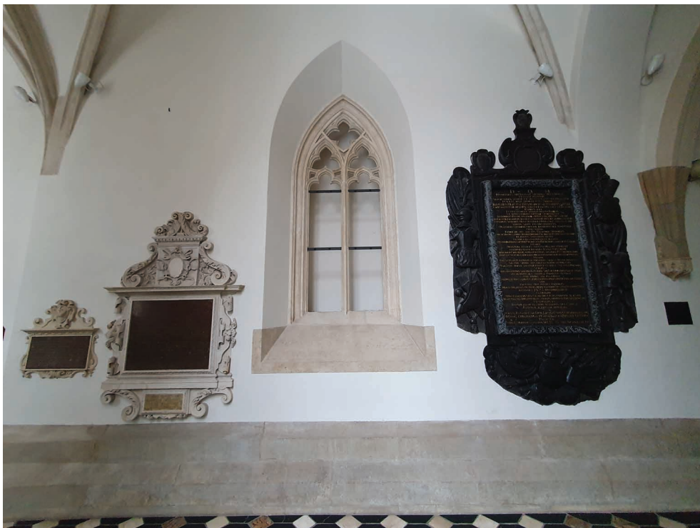
11. Kraków, klasztor dominikanów, południowy trakt krużganka; zamurwane okno w północnym murze obwodowym korpusu nawowego. Fot. Marcin Szyma
