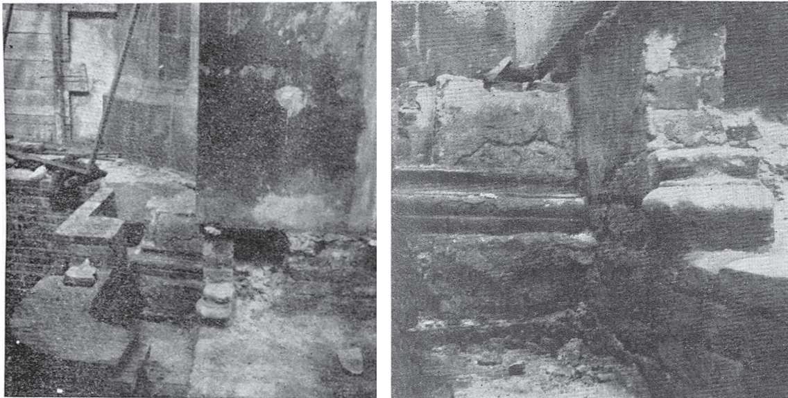
5–6. Kraków, kościół dominikanów, baza półfilara w nawie, po północnej stronie arkady tęczowej i bazy kolumnienek przegrody chórowej po odsłonięciu w 1938 r.; baza półfilara w nawie, po północnej stronie arkady tęczowej i baza północnej kolumnienki przegrody chórowej po odsłonięciu w 1938 r. Repr. wg Józef Jamroz, Średniowieczna architektura dominikańska w Krakowie , „Rocznik Krakowski” 1970, s. 22, 17
