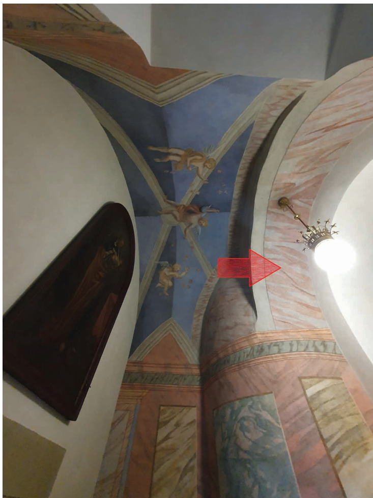
30. Kraków, kościół dominikanów, przedsionek zakrystii publicznej; arkada w ścianie zamykającej pierwotnie niszę pierwszej kaplicy św. Jacka, po lewej kolista klatka schodowa, niegdyś prowadząca na piętro lektorium i strych kościoła. Fot. Marcin Szyma
