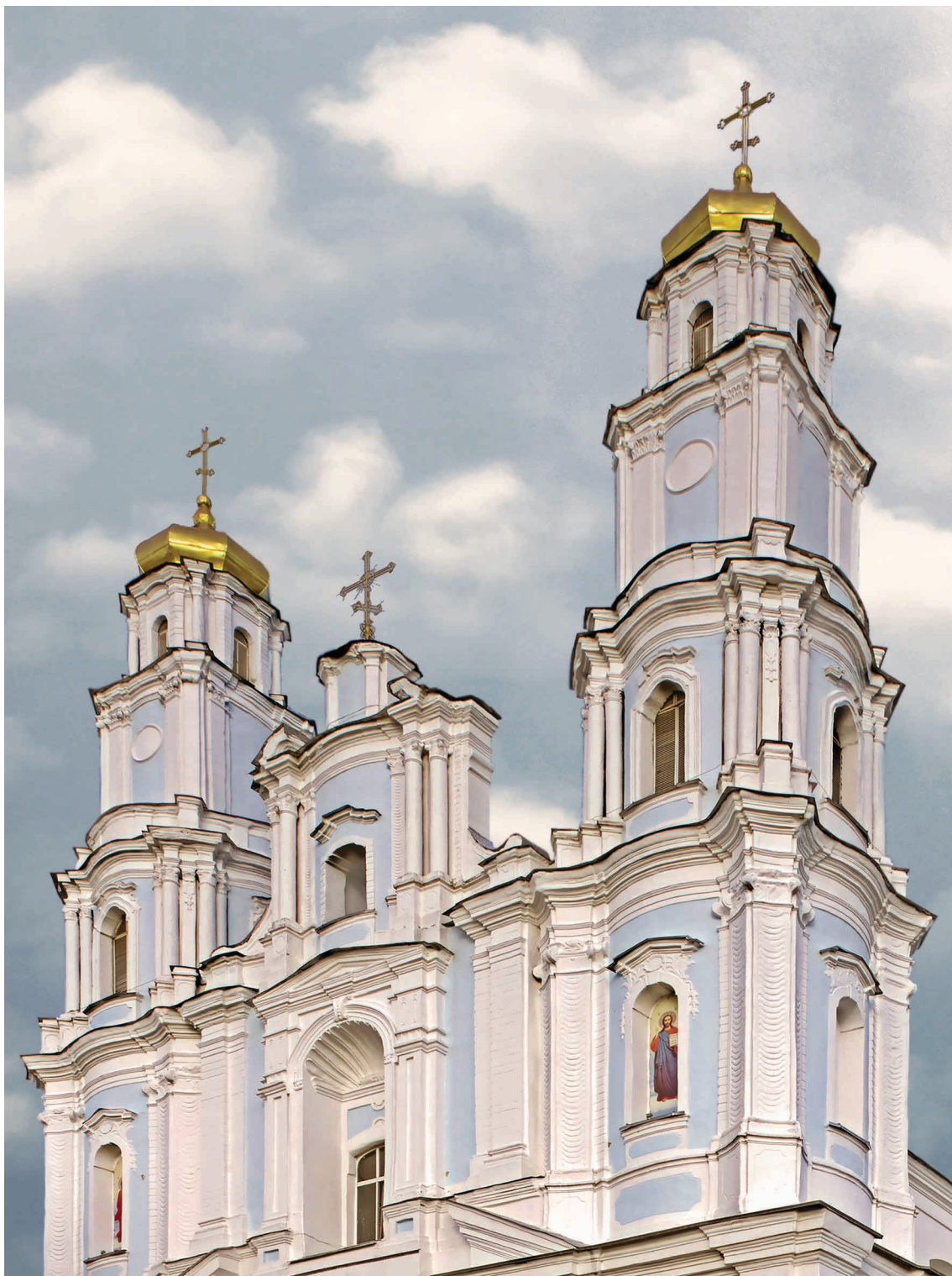
11. Abraham Würtzner (?), fasada kościoła karmelitów bosych w Głębokiem, przed 1755, fragment. Fot. Piotr Jamski
