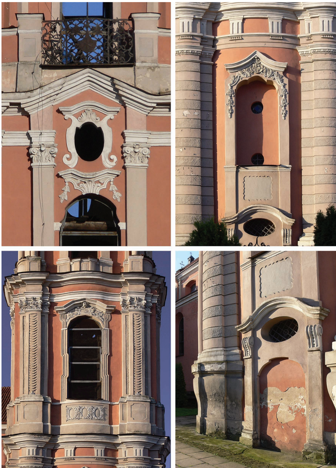
3. Abraham Würtzner (?), dzwonnica kościoła karmelitów trzewickowych pw. Wszystkich Świętych w Wilnie, detale I-III kondygnacji. Fot. Wojciech Boberski
